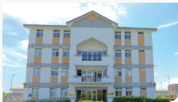
宜蘭科學園區污水處理廠
